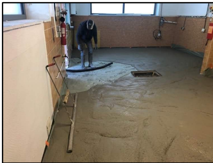
Réfection de la cuisine de la Salle des fêtes - Réalisation d'une chape de ragréage par les Ets Laloux de Doullers
