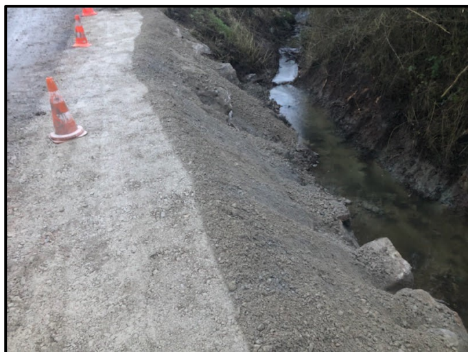
Consolidation d'un bas-côté au chemin de la Marlière Réalisé par les Ets Thomas de Cartignies
