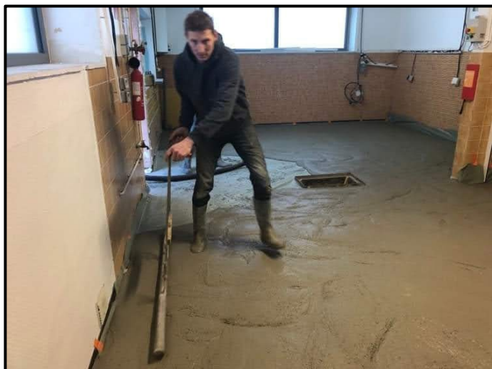
Réfection de la cuisine de la Salle des fêtes - Réalisation d'une chape de ragréage par les Ets Laloux de Doullers
