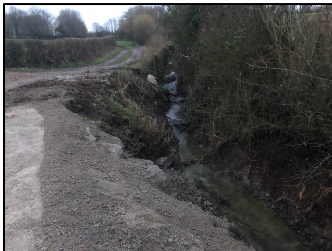
Consolidation d'un bas-côté au chemin de la Marlière Réalisé par les Ets Thomas de Cartignies
